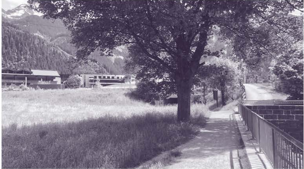
Abb. 36 | Foto Richtung Süden | Unterführung und Radweg
